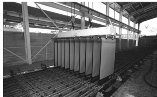
Εικόνα 3: Κάθοδοι χαλκού στο τμήμα ηλεκτρόλυσης
